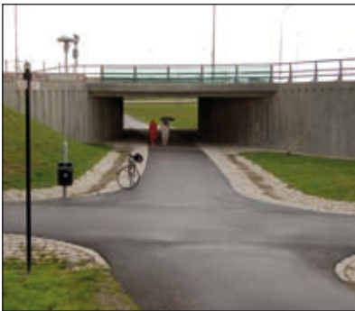
Cykeltunnlar ska vara bra utformade och ha ändamålsenlig belysning.
