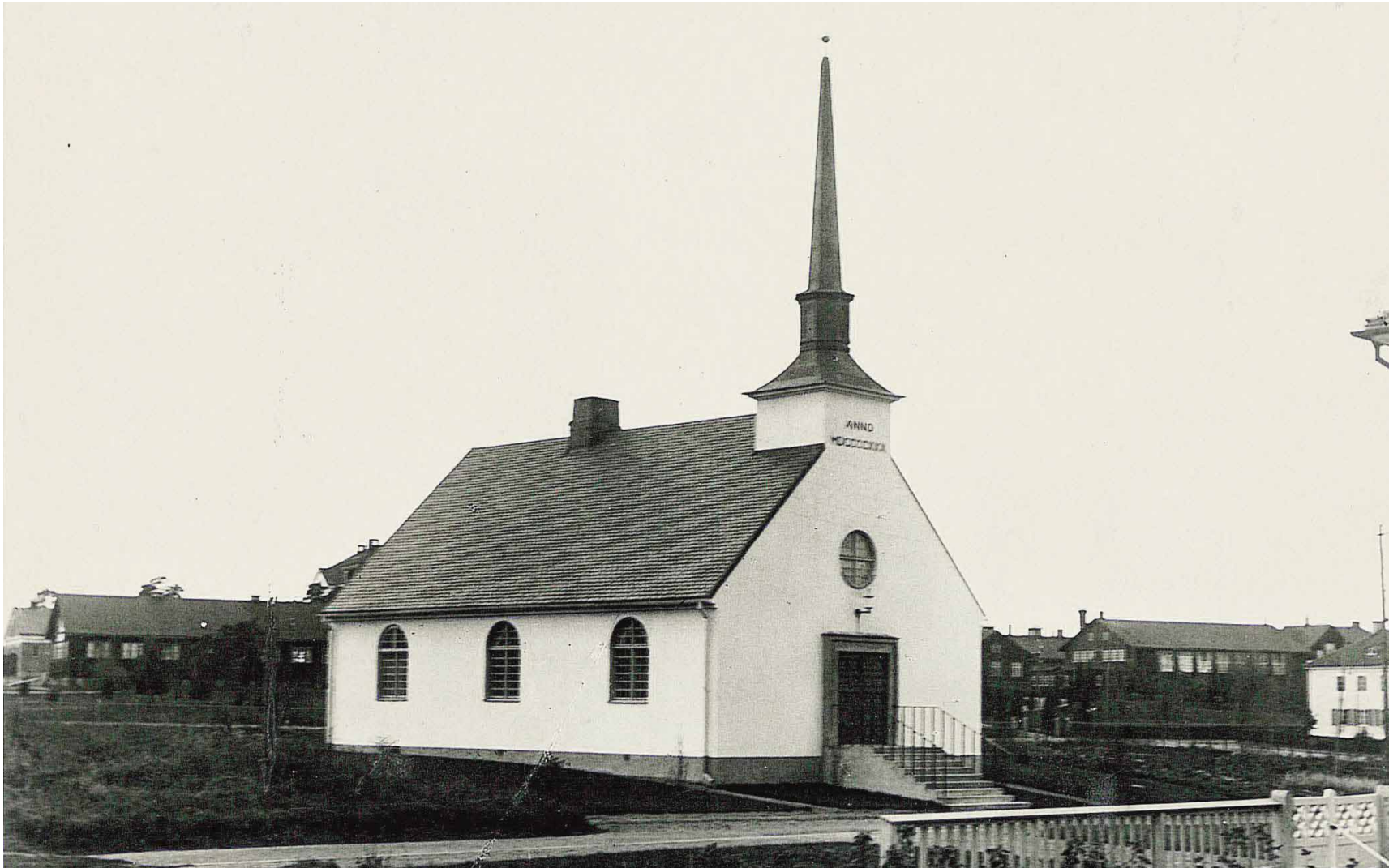
Foto av kapellet år 1932, strax efter uppförandet. I bakgrunden syns regementet T I:s byggnader vilket visar på att varken park eller bebyggelse runt om var uppförd i samband med att kapellet byggdes, Östergötlands museum.
