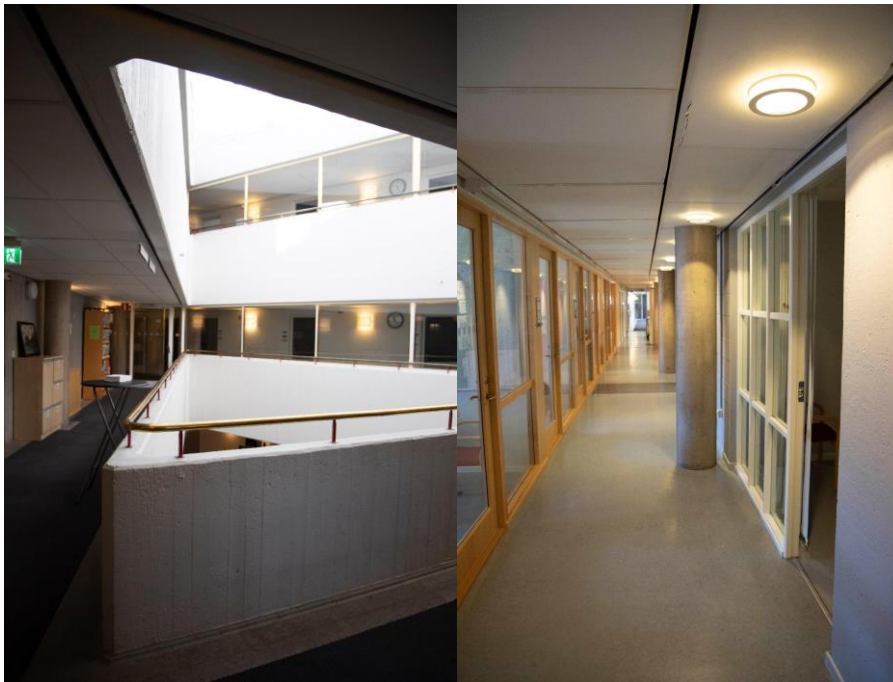
Bild. Till vänster. De ursprungliga räckena i ljusschakten. Till höger. Korridor i landsstatshuset där de fristående betongpelarna syns.
