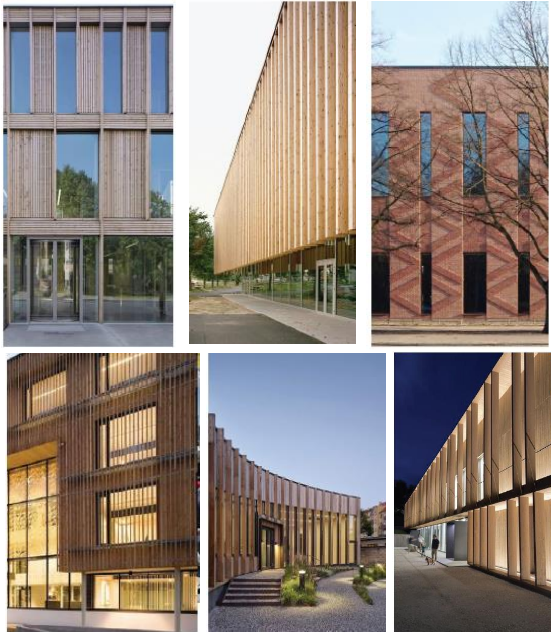
Bild 18. Referensbilder från Tengboms underlag för gestaltning av multihallen som visar på utförande med helt eller delvis uppglasade/transparenta markplan. (Tengbom)
