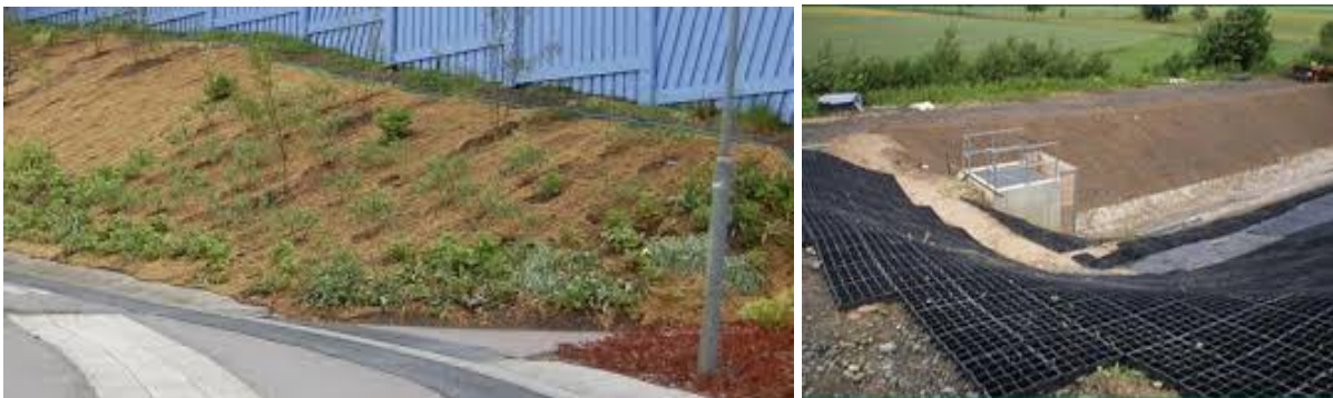
Fig. 9. Erosionsskydd av kokosmatta respektive plastmaterial.
