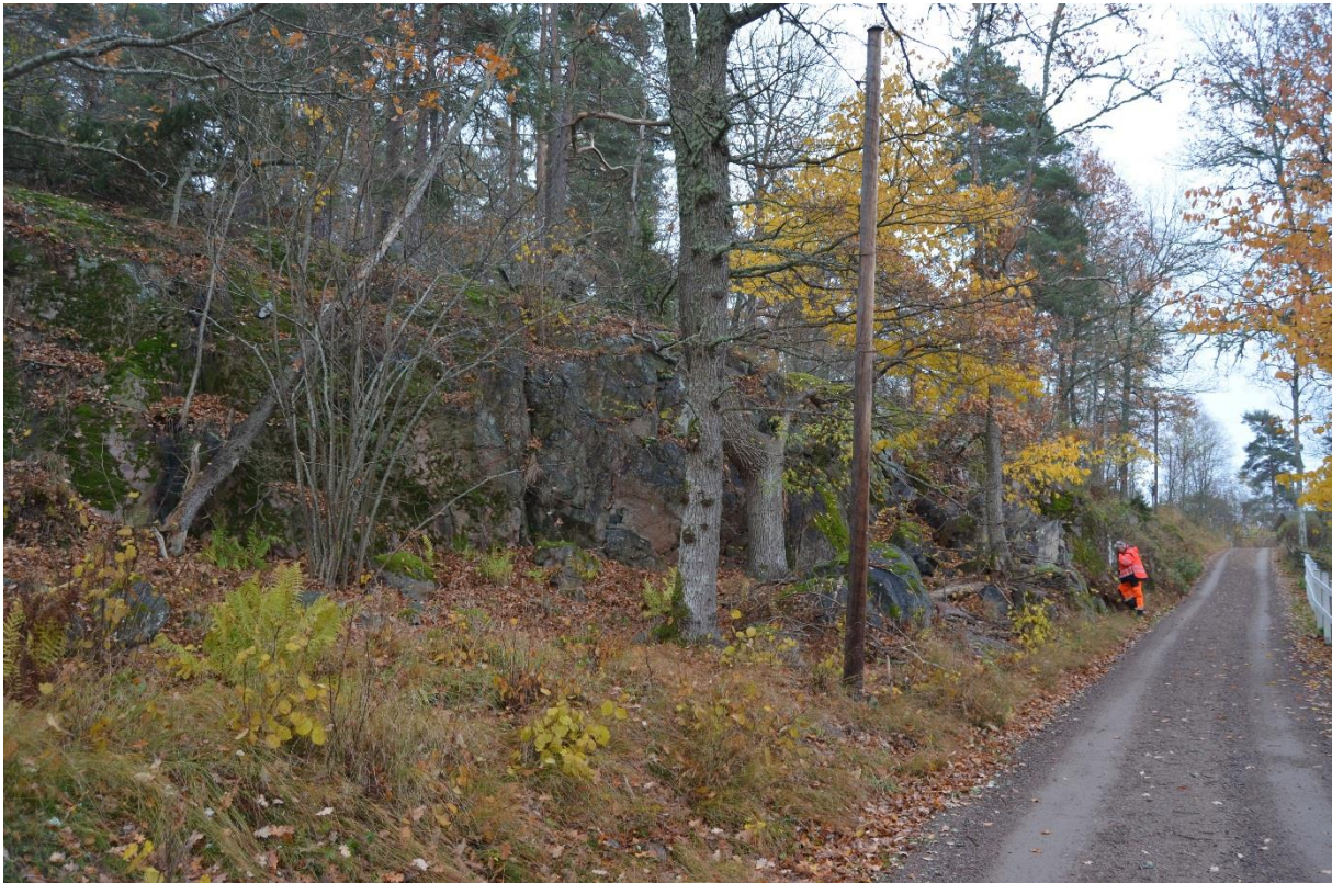
Figur.5 brant del av slänt B5 utmed Roxenbadenvägen. Om VA-schakt skall utföras längs vägen bör det trånga utrymmet nämnas i förfrågningsunderlag. Bergschakt är med största sannolikhet nödvändig.
