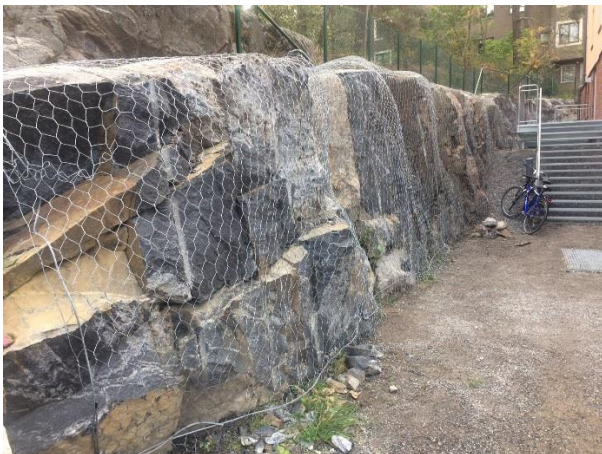
Fig.10 bergsäkring med gabionnät utfört av Bergcon AB.
