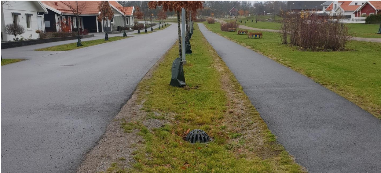
Figur 5. Exempel på ett grunt svackdike med kupolsil. Foto: Dämningsverket 2018.
