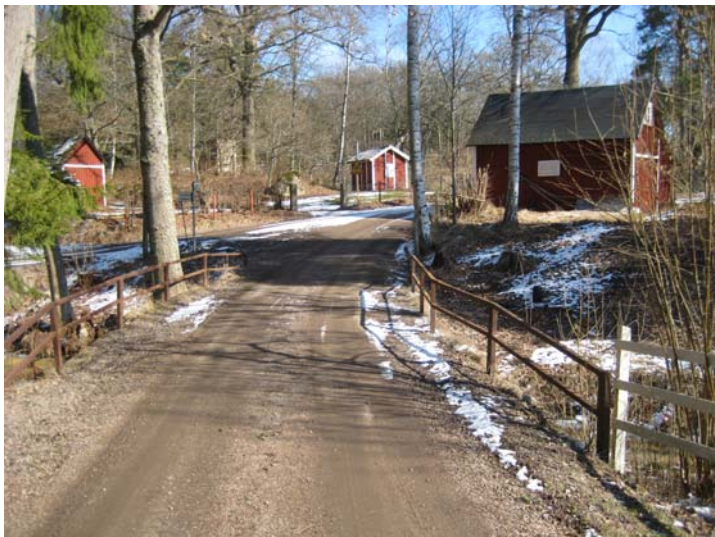
Bild 19. Punkt E9, skymd sikt i korsningen samt två mindre broar.
