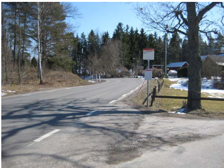
Bild 27. Punkt 2, skymd sikt i kurvan i anslutning med busshållplats.
