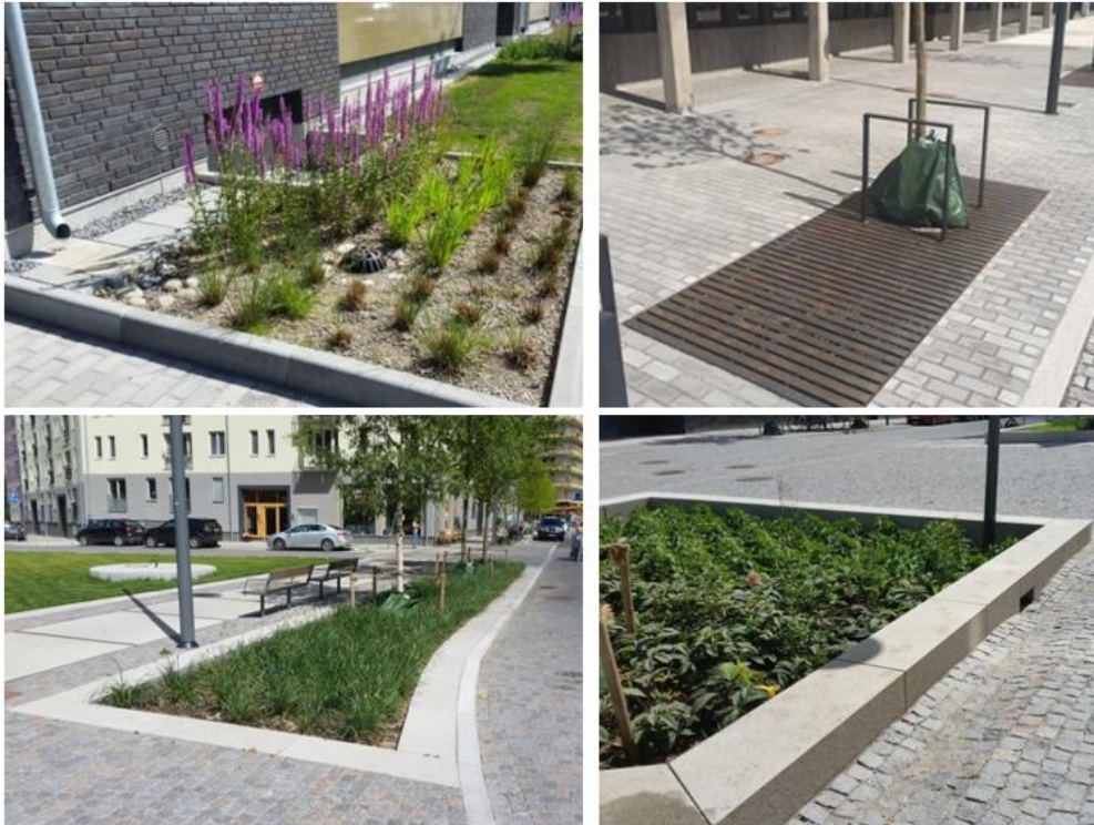
Figur 18 Växtbäddar. Ö.t.v. inledning via stuprörsutkastare, ö.t.h. växtbädd med markgaller, n.t.h inloppet via öppning i kantsten och n.t.v. inlopp på bred front via nollad kantsten.
