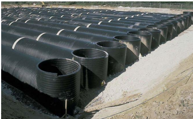
Figur 17 Rörmagasin. Källa: www.kwhpipe.se
