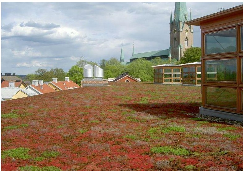
Figur 19 Sedumtak stadsbiblioteket i Linköping. Källa: www.vegtech.se .
