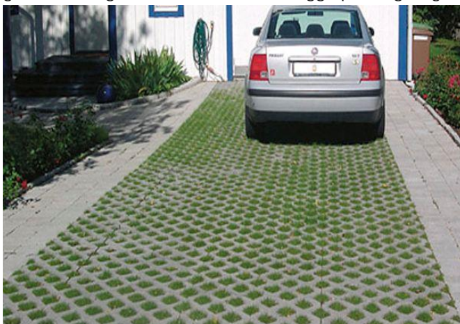
Figur 20 Gräsarmering på garageuppfart. Källa: www.alltimark.se
