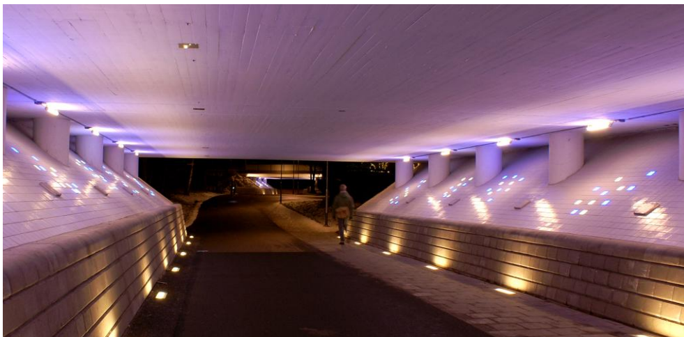
Figur 6.4 Två gång- och cykeltunnlar i anslutning till Linköpings Universitet.
