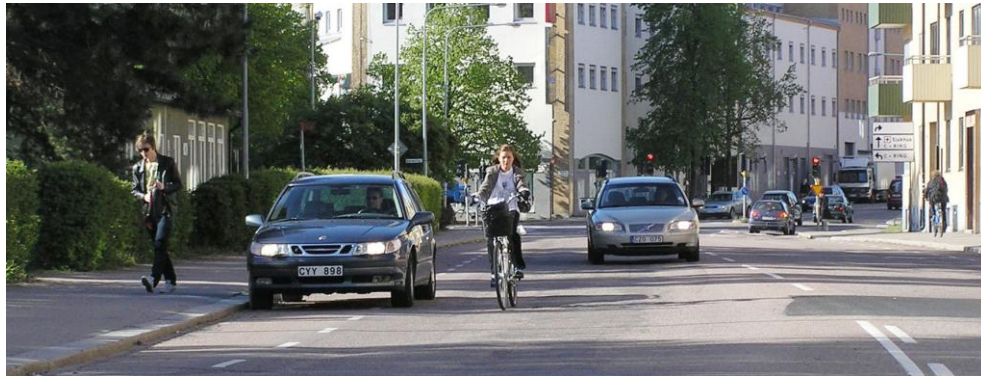
Figur 7.2 Längs med delar av Östgötagatan cyklar man idag i blandtrafik. Genom att minska bredden på bilkörfälten byggs under 2009 ytterligare en sträcka med cykelbanor på båda sidor.
