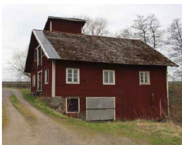
Ginkelösa kvarn, en av byggnaderna inom karaktärsområdet som har fått bestämmelserna f och f , q och r , foto från Kulturmiljöunderlag för Vårdsberg, Linköping 2016.
