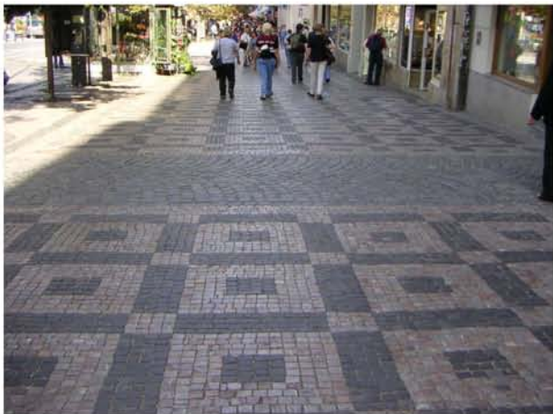
Markmaterial och mönstersättning i gatumark, Prag
