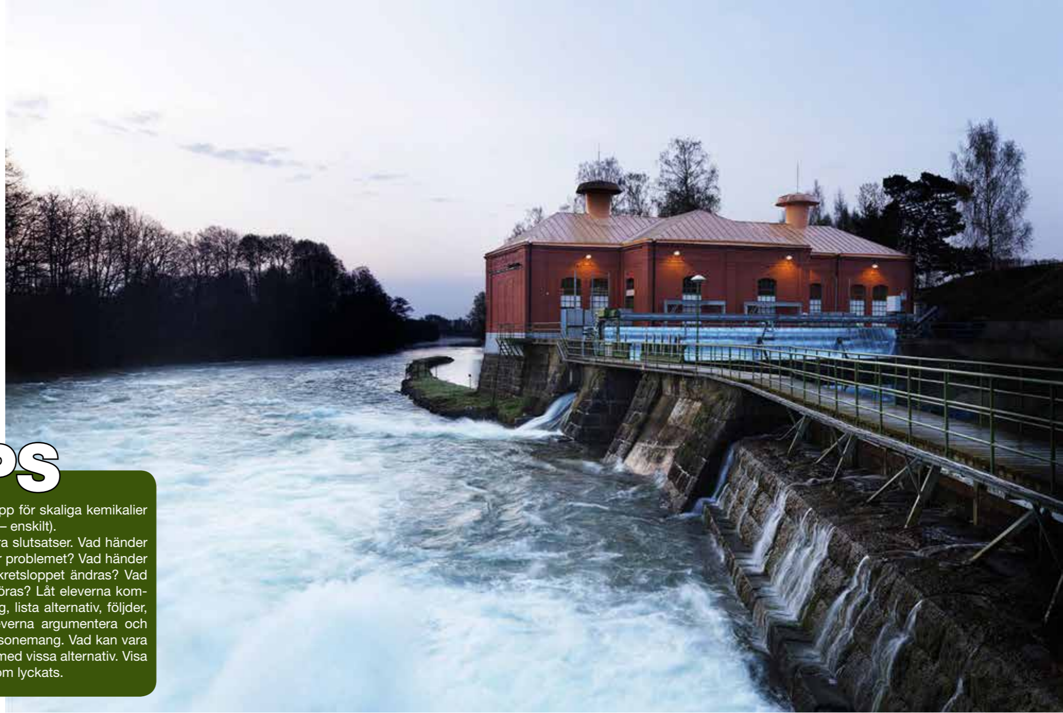
Nykvarn vattenkraftverk i Linköping Foto: Tekniska verken
