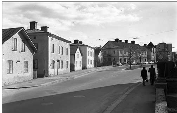
Djurgårdsgatan 1960. Bilden är tagen i höjd med det läge där Föreningsgatan idag ansluter Djurgårdsgatan. I bakgrunden skymtar det höga punkthuset vid Eskadern.
