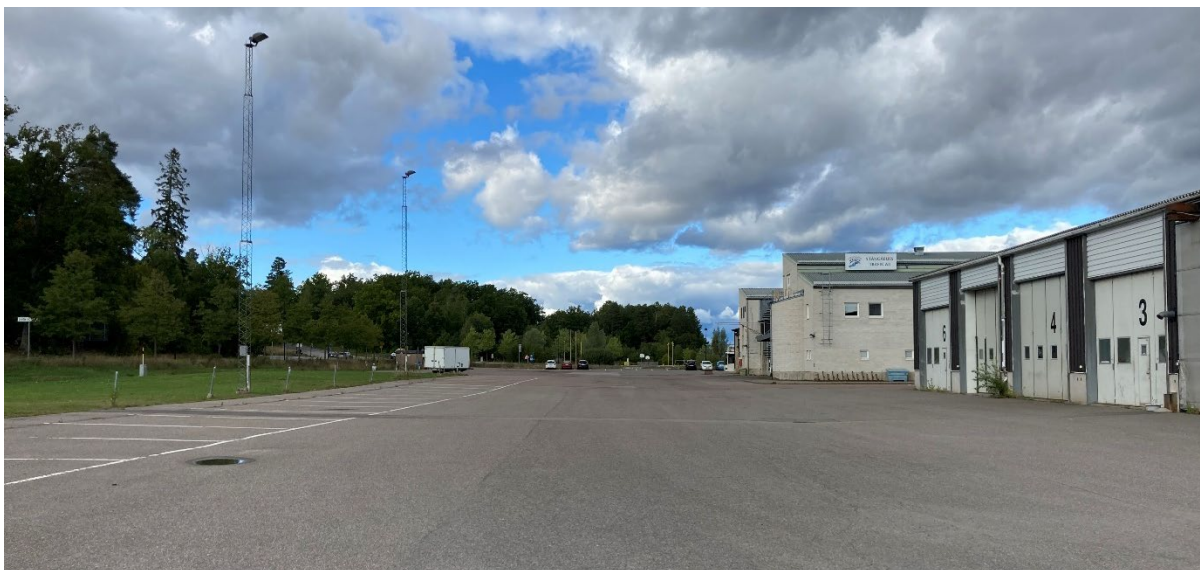
Figur 2. Vy från söder mot västra delen av garagebyggnaderna inom Eldstålet 1.
