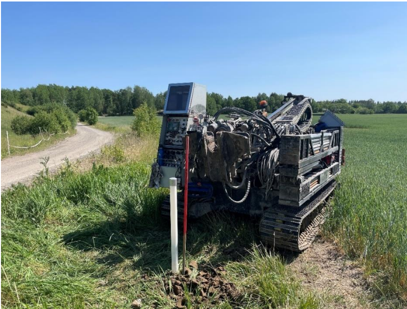
Figur 4. Installation av rör 23SW02, fotograferat av Sweco 2023-06-13.
