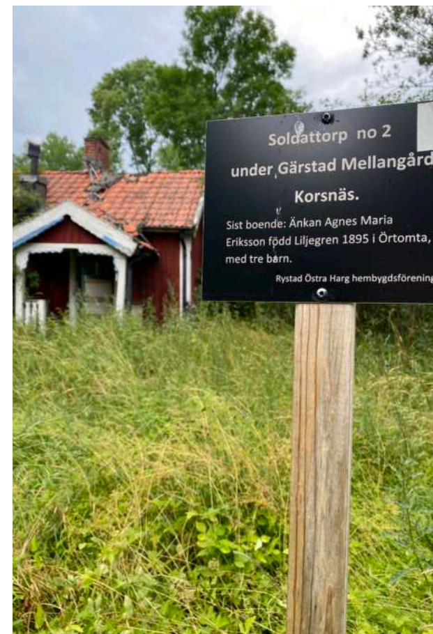
Figur 56. Soldattorpet Korsnäs. Taket håller på att rasa in och det saknas fönster.
