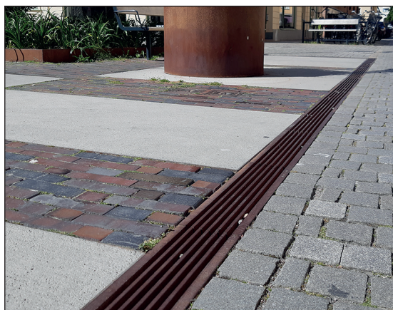
Exempel på linjeavtättning på Hospitalstorget/Nygatan.
